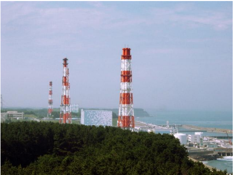
La centrale nucleare di Fukushima, nel 2011 subì un grave danno a causa di un terremoto.
