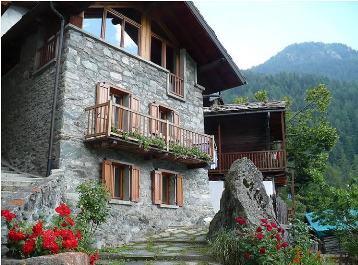
Casa tipica valdostana a Crétaz (pron. Créta), frazione di Valtournenche.
